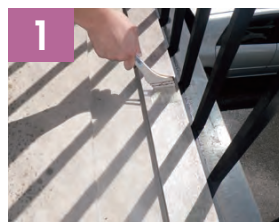
1 下地全面に レツスステップ専用プライマー塗布
