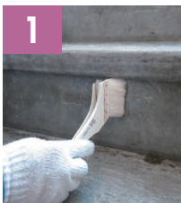
蹴込み部全面にレッツステップ専用プライマー塗布
