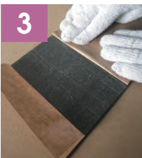
剥離紙の折り曲げ(左右に15cm程度)
