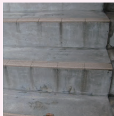
モルタル＋クリンカータイル埋め込み階段
