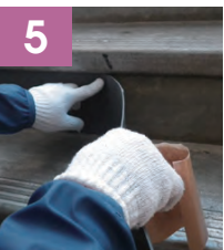
下地への全面固定
