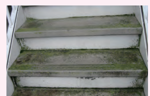
カビやコケの付着した下地（洗浄して除去してください）
