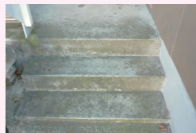
コンクリート下地
