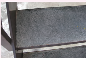
モルタル充填 金属階段
