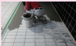
スカイレジンエポフィラー施工
