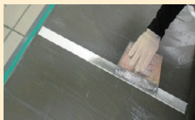
ジョイントシート施工
